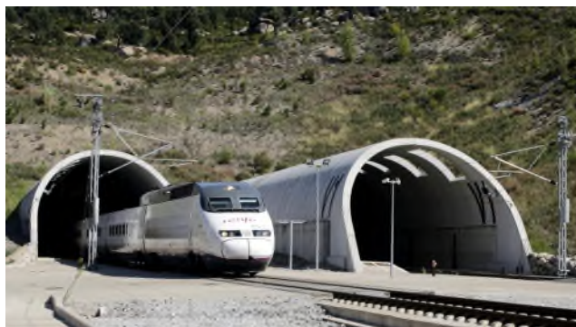
Pertús Tunnel (HSL Figueres-Perpignan)
